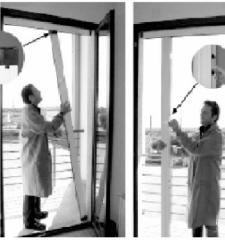
Τοποθετήστε τα ειδικά πλαστικά άγκιστρα τοποθέτησης στο πίσω μέρος της σήτας και κατόπιν αφαιρέστε την αυτοκόλλητη ταινία διπλής
